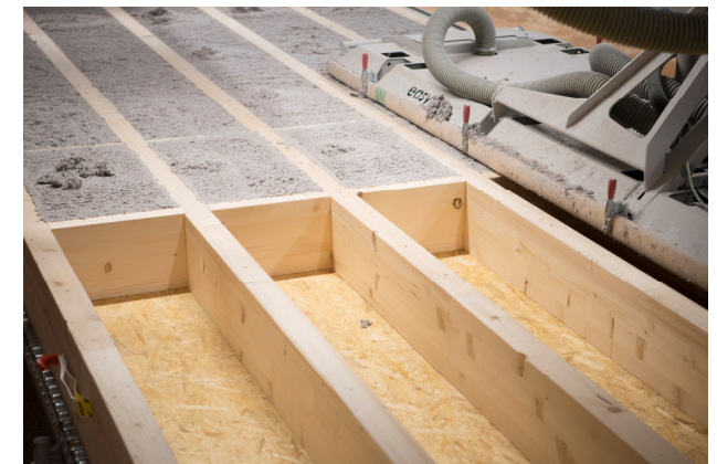
Dämmen mit Zellulose, Flumroc, Schafwolle, Hobelspänen
