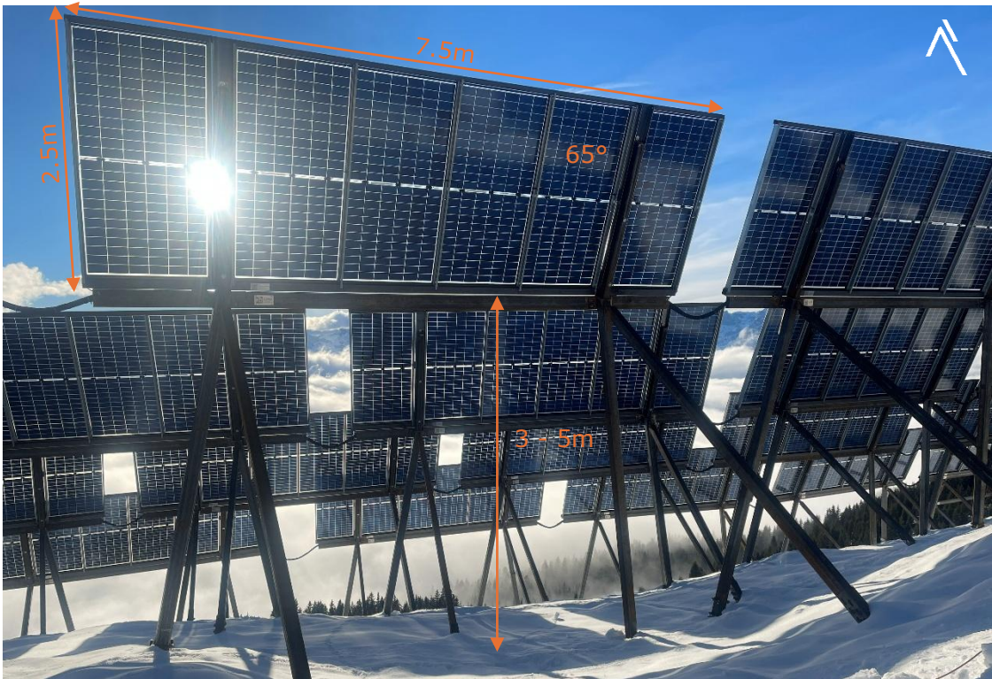
ALPIN QUATTRO ® Tische im Projekt APV Sidenplangg, Spiringen (energieUri, aventron), Quelle: APV Sidenplangg, ZENDRA
