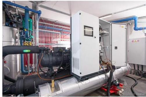
Abbildung 27: OCHSNER Höchsttemperatur Wärmepumpe IWDS 330 ER3 (Zauner, 2016).
