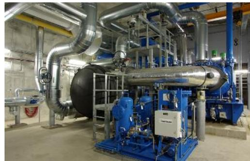
Abbildung 30: Links: Arbeitsbereiche der Unitop Wärmepumpen (Friotherm AG, 2005)<sup>33</sup>, Rechts: Unitop 50 Wärmepumpe, Helsinki Energia.
