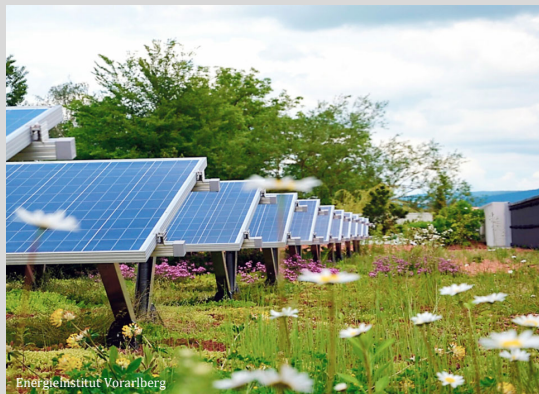
Module höher aufgeständert auf Substrat ballastiert
