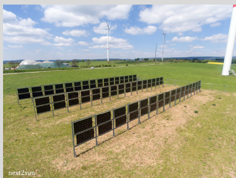
Bifaciale Module nutzen Strahlung von beiden Seiten
