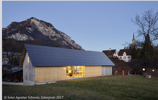
Hinterlüftung kühlt die Module
