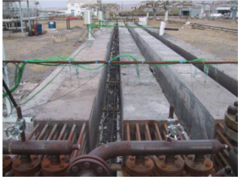
Betonspeicher ohne Isolation Vier Module von je 80kWh Quelle [22]
