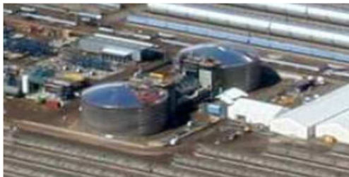
Nitrat-Salz Speicher Andasol in Spanien mit 14'000m 3 Speicher, gemäss Kapitel 4.3 Quelle [22]
